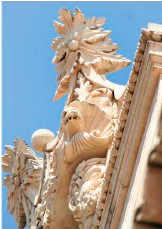
Siracusa. Palazzo Impellizzeri. Particolare del cornicione di coronamento.
