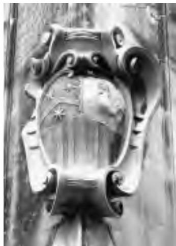
7. Siracusa, palazzo Impellizzeri Vianisi. Particolare del cornicione di coronamento.
